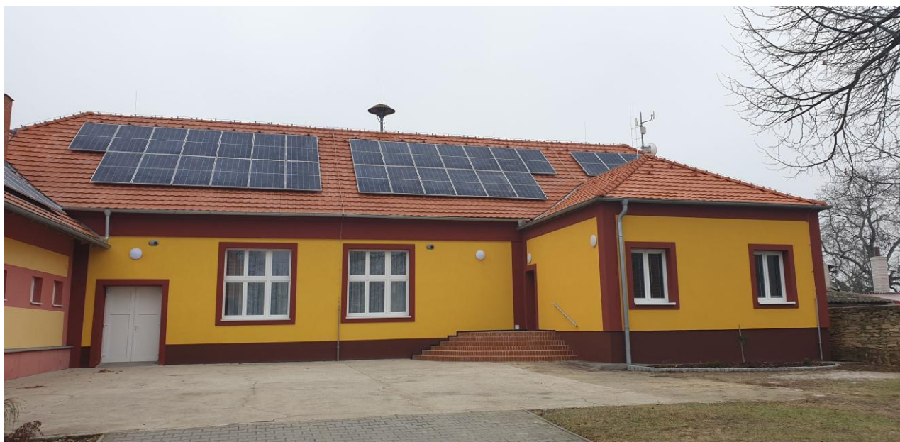
Rekonstrukce multifunkční budovy
