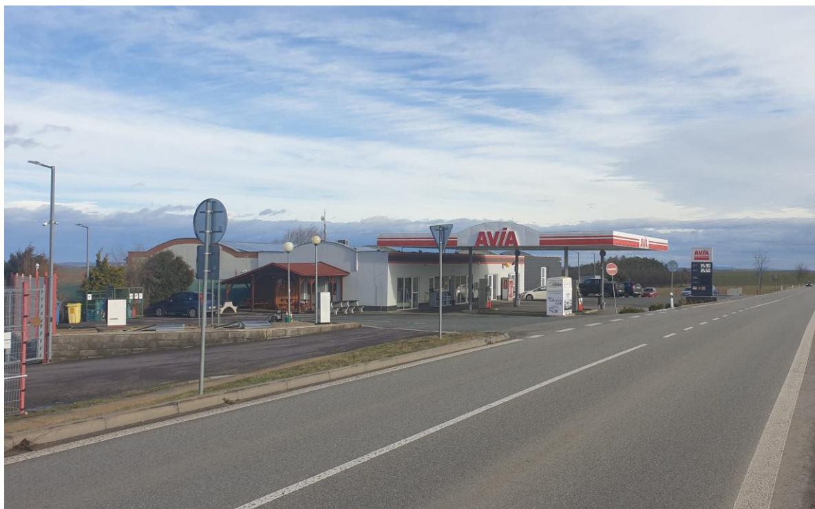
Milíčovice – čerpací stanice
